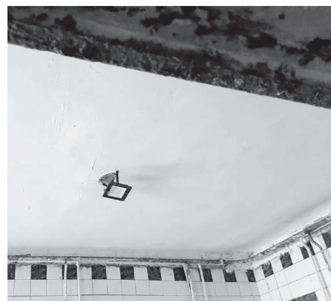
Во всех помещениях провели косметический ремонт
