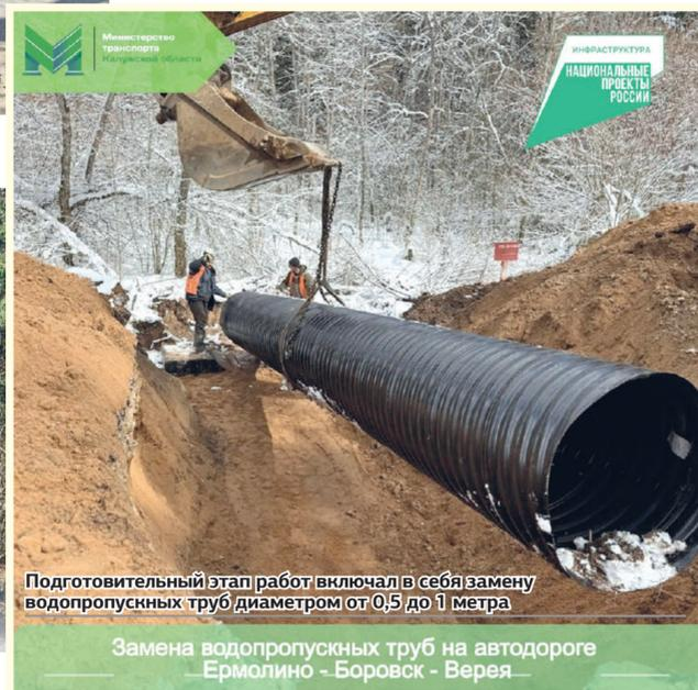
Подготовительный этап работ включал в себя замену водопропускных труб диаметром от 0,5 до 1 метра
